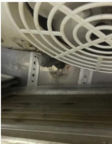
Mimbres de la cámara donde se puede ver que hay una bandeja para evitar el goteo y que caiga sobre los alimentos, además de producir óxido en dicha cámara.
